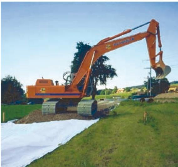
**Kiespisten sind eine geeignete lastverteilende Massnahme zur Vermeidung von Verdichtungen.**
